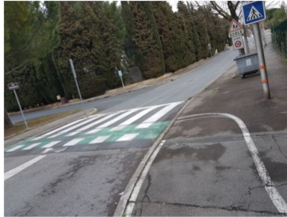
Rue de l'Engabanac
