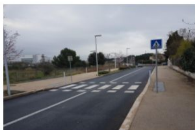
Traversée Rue des Jasses.
