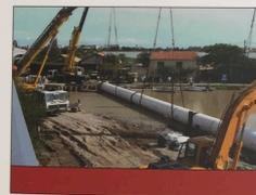
Le tronçon LAGUNAIRE, de la Mosson à la mer, longue sur 4,3 km les étangs. Dans des terrains vaseux, il est constitué d'éléments en ACIER soudés. Il comprend un ouvrage qui pourra être équipé à l'avenir de pompes pour le refoulement en mer.
