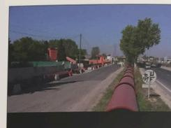
Le tronçon TERRESTRE, de la station MAERA à la rivière Mosson, longue sur 4,8 km la route départementale 986. Construit dans des terrains porteurs, il est réalisé en éléments de FONTE emboîtés avec joints.
